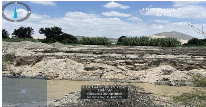
FIGURA 01: Tramo crítico en el río Ica sector Santiago 1, se muestra que se ha erosionado en la margen derecha perdiéndose áreas de cultivo aguas abajo
