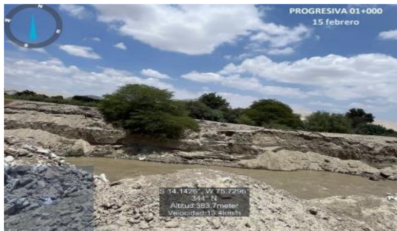
FIGURA 02: Tramo crítico en el río Ica Taludes erosionados para mantenimiento del cauce
